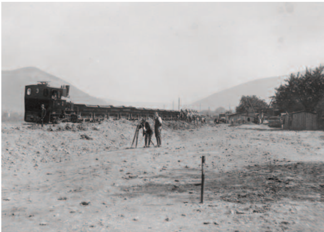
Abbildung 15 | Vermessung des Baugebietes für das Wehr Wieblingen am Neckar, September 1922 Quelle: Bundesanstalt für Wasserbau, HB 1895
